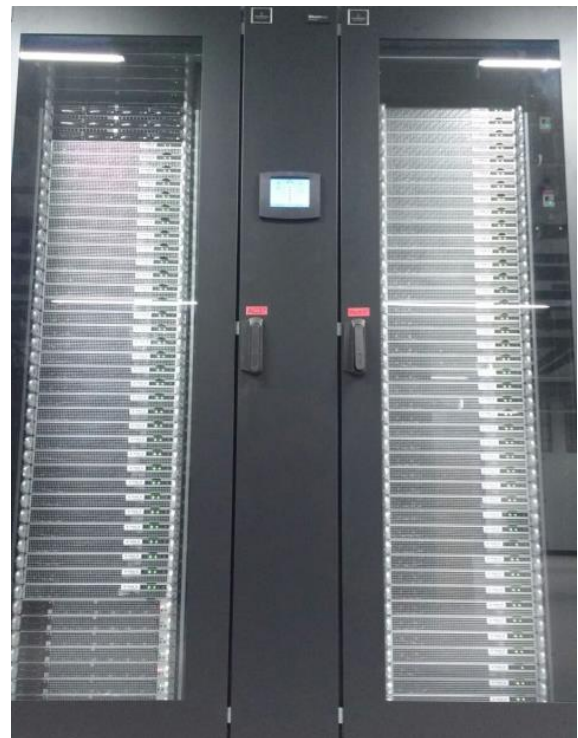
Rack 1 + 2 mit je 42x MUSTANG® systems/ Supermicro BTO 1U SuperServer inkl. je 1x E5-2630v4+NVIDIA GTX 1070/GTX1080...
